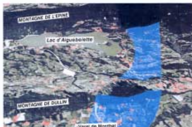
13 Les montagnes de Dulin et de l'Épine sont franchies en tunnel.
